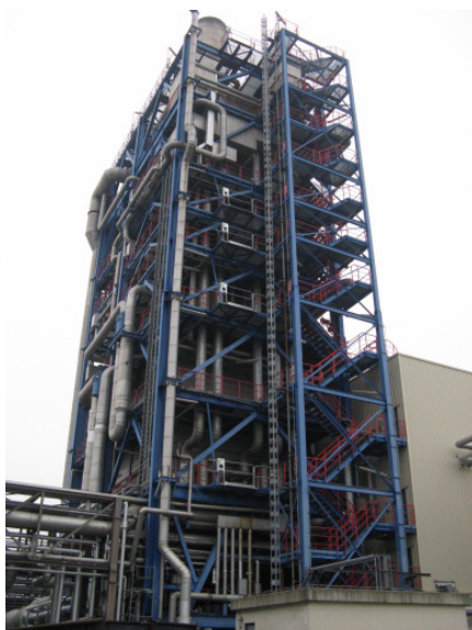
Bild 2: der Mast und die oberen 5 Haltestellen vom Aufzug Kesselhaus
