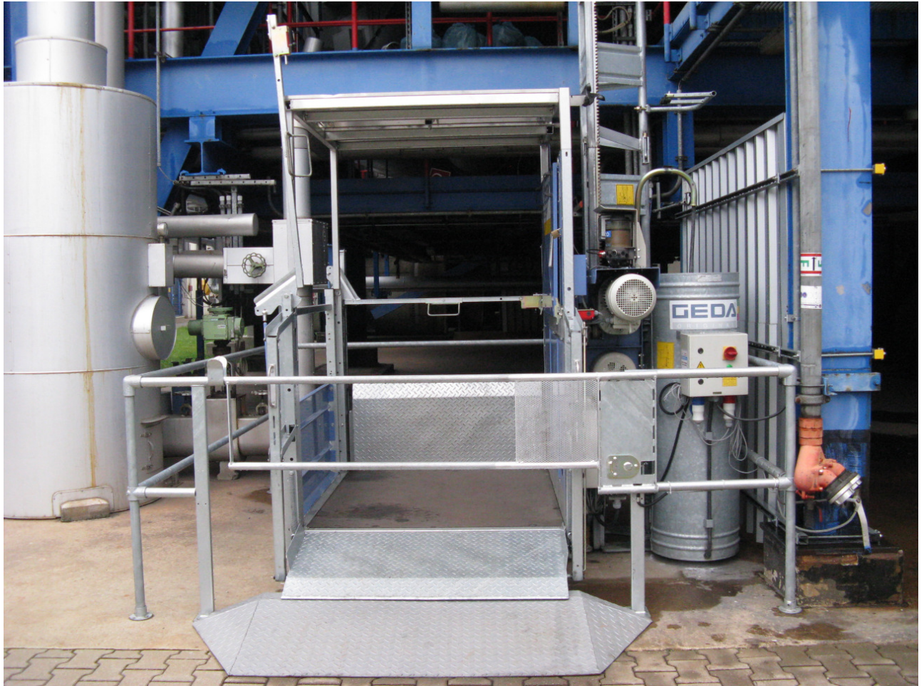
Bild 1: Aufzug Kesselhaus mit Fahrkorb, Antrieb, Schleppkabeltopf und dem unteren Teil vom Mast
