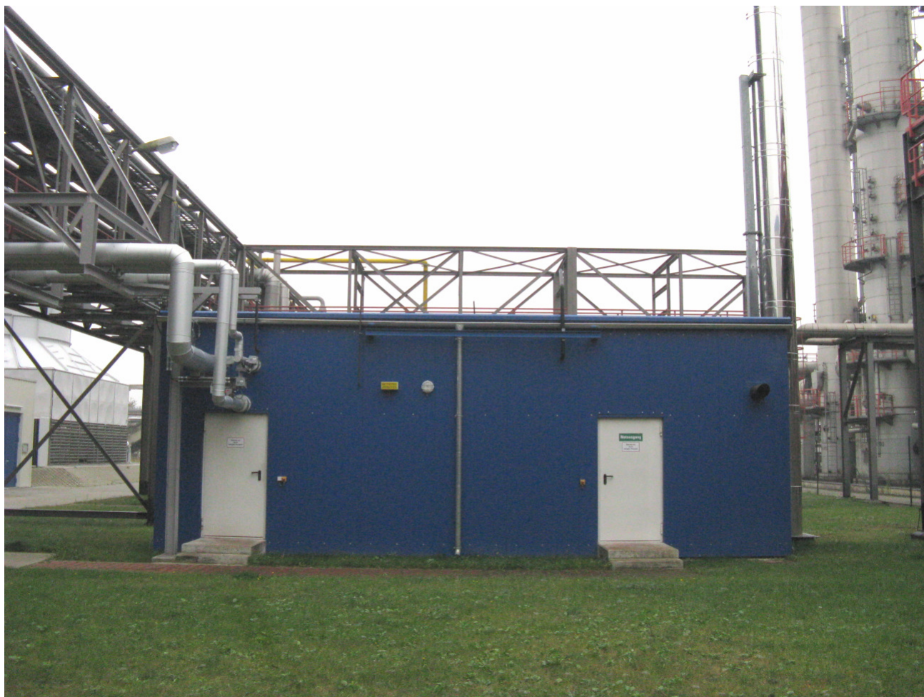
Bild 1: Hilfsdampfkessel-Container mit Medienanschlüssen
