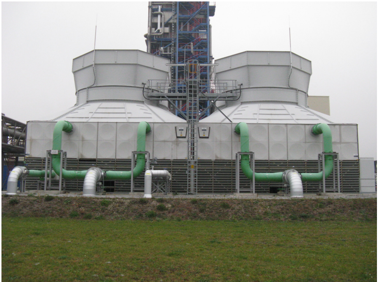
Bild 1: Zellenkühltürme 1 und 2 mit Kühlwasserzulauf (Warmwasser)
