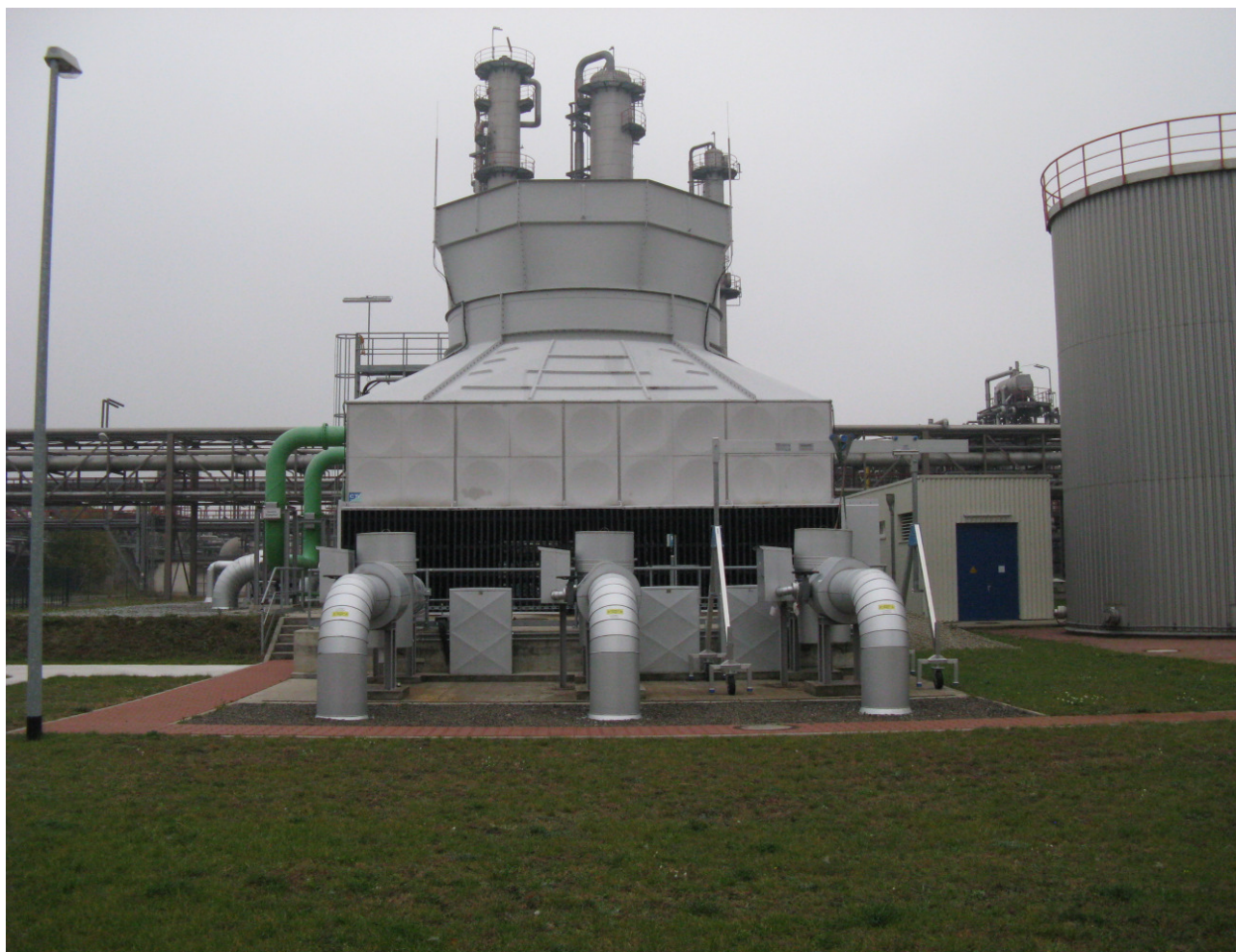
Bild 2: Zellenkühlturm mit Kühlwasserpumpenschacht
